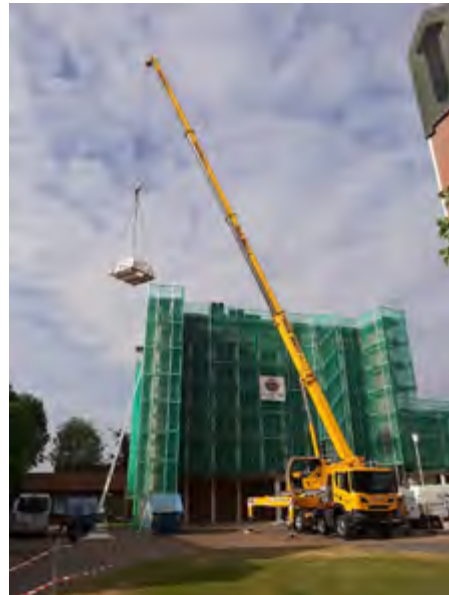
Die neuen Glaskuppeln werden auf das Dach gehoben
